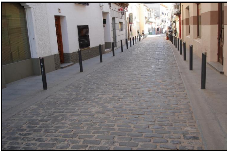
Pavimentado de la calle la Cárcel
