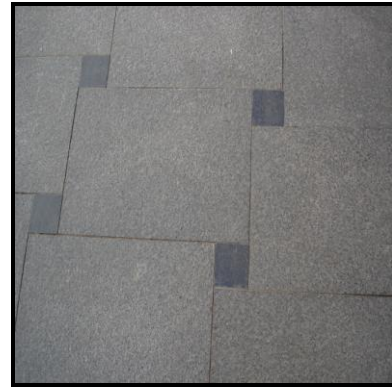
Detalle del pavimento de la Calle Empedrada.
